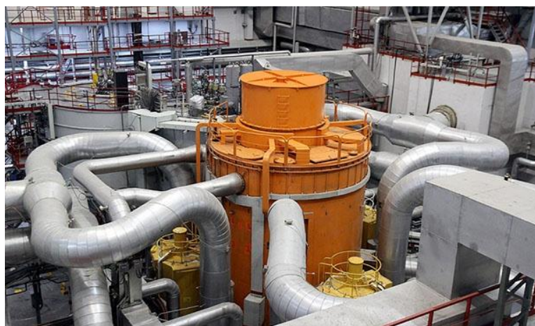
Рис. 3. АВЦ-5000/115-6000/660-6/24УХЛ4, центральный зал БН-800 Белоярской АЭС
